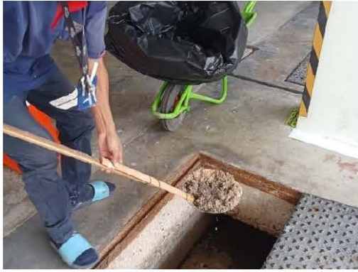
ช่างประจำอาคารขณะตรวจสอบระบบบำบัดน้ำเสีย
