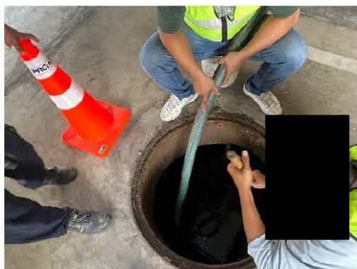
การสูบน้ำก่อนระบบบำบัดน้ำเสีย
